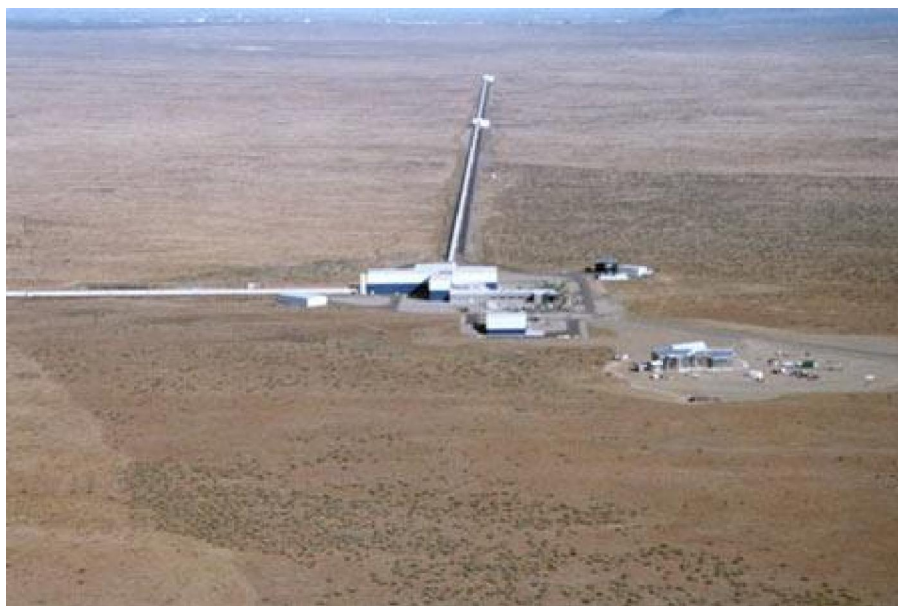
LIGO 探测器正在建设中
