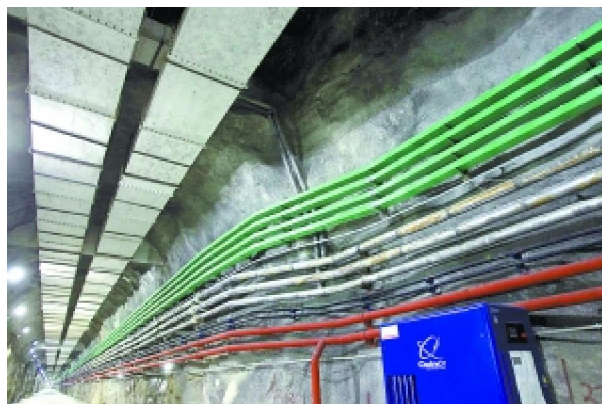
通往大亚湾中微子实验厅的隧道。
