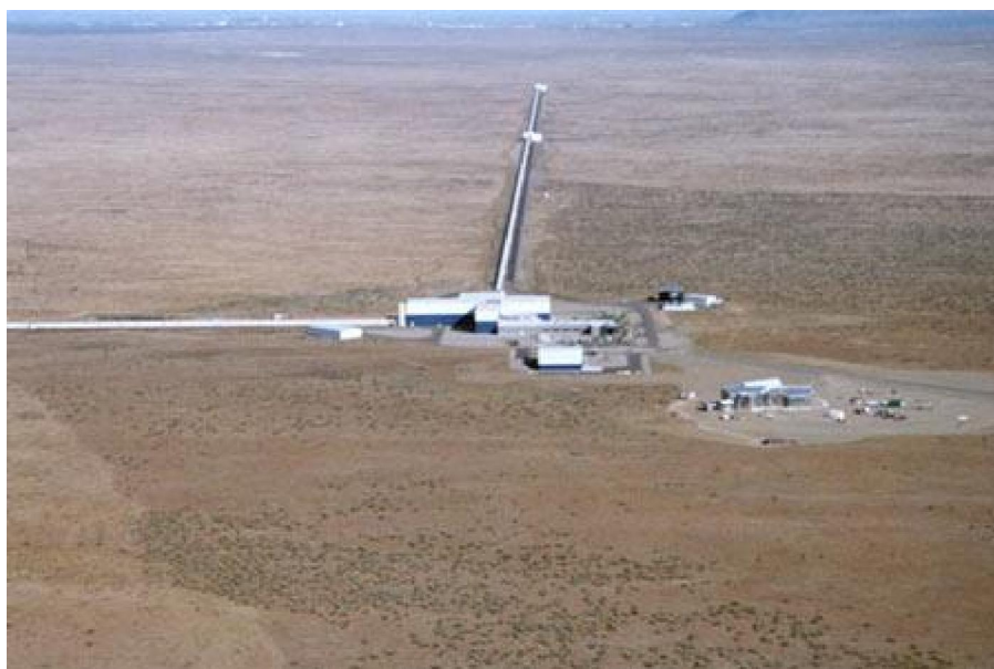
LIGO 探测器正在建设中
