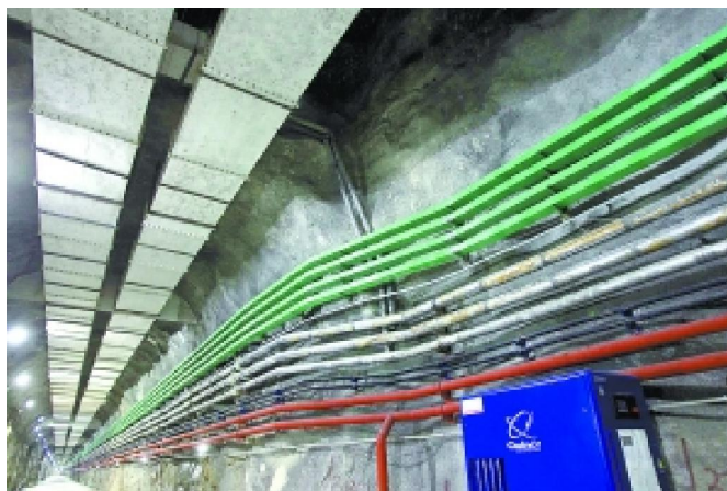
通往大亚湾中微子实验厅的隧道
