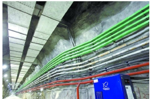
通往大亚湾中微子实验厅的隧道。
