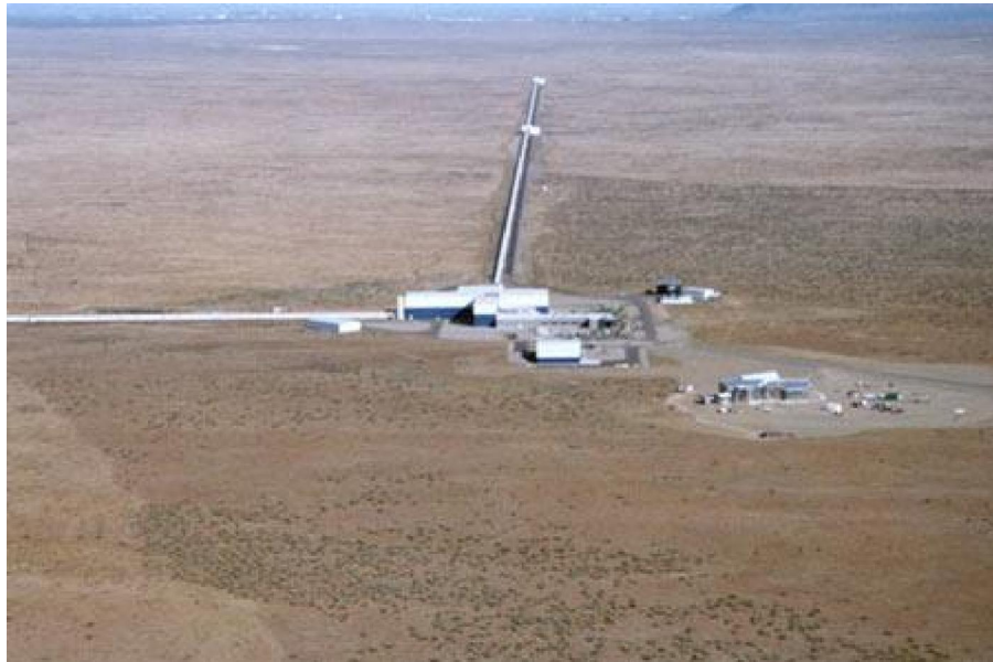
LIGO 探测器正在建设中
